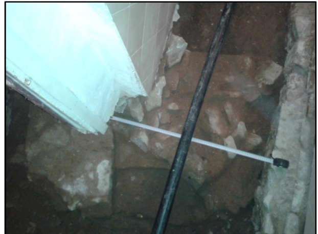
F10.- A la cantonada esquerra podem observar el mur UE 35. Adossant-se a aquest veiem l'estructura UE 29 i part del mur UE 33.
