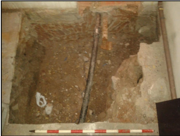
F1.- Foto inicial de l'emplaçament del forat d'ascensor.
