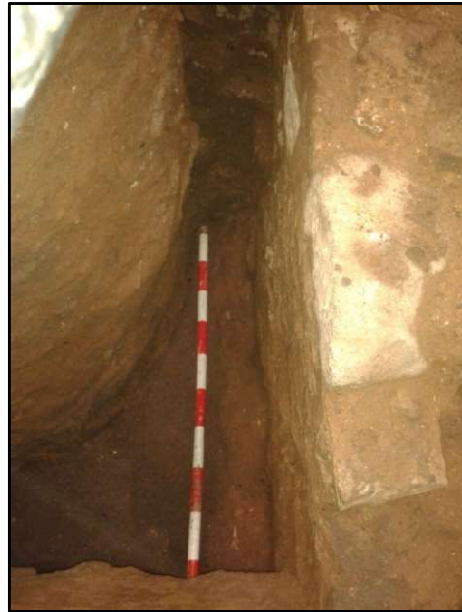
F8.- Fonamentació (UE 16) del mur UE 10 i la seva ampliació UE 35.
