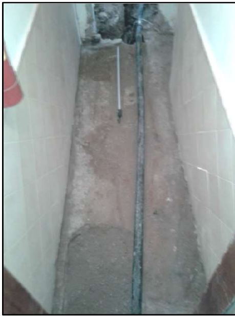
F9.- Tram del passadís on podem observar la UE 26. A la cantonada inferior esquerra podem observar el retall UE 24.
